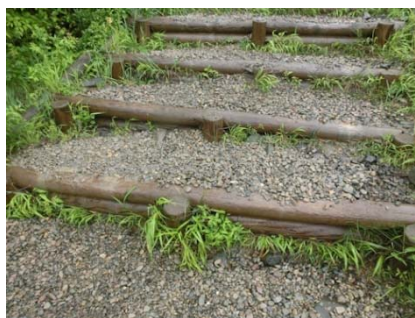
仕上がった階段部分
