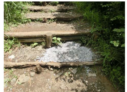
階段の踏面に砂利を敷きこむ
